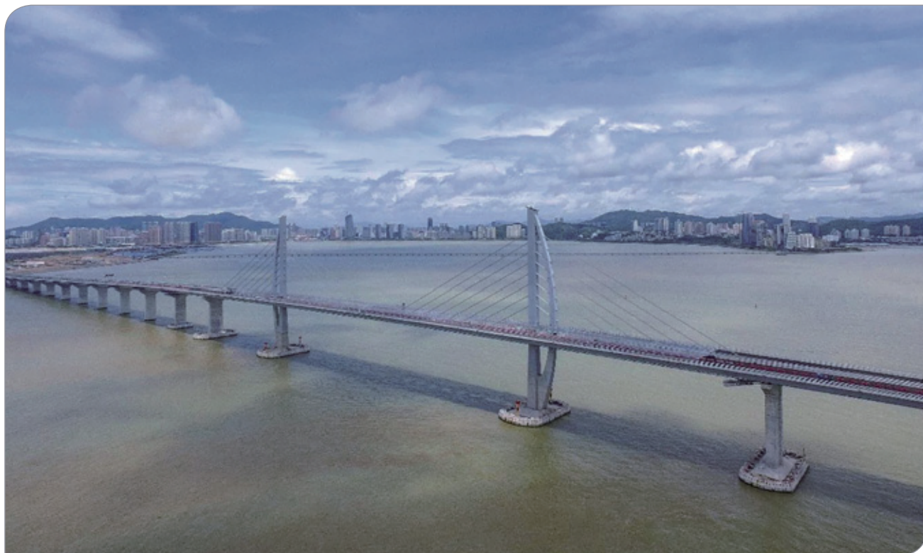
香港 - 珠海 - 澳门大桥
